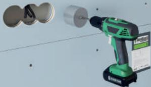
После монтажа звукоизоляционного гипсокартона Gipsolon ПЛУК в нем коронкой просверливается отверстие в месте установки подрозетника.
