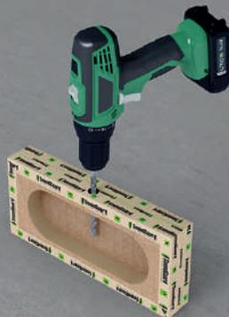
В подрозетнике SoundGuard Изобокс Премиум просверливается отверстие для выпуска проводов. Место выхода электропровода заполняется виброакустическим герметиком SoundGuard Seal.
