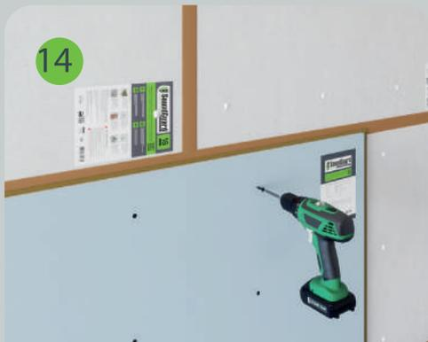
Звукоизоляционный гипсокартон Gipsoson ПЛУК монтируется совместно с мембраной и крепится к поверхности звукоизоляционных панелей саморезами SoundGuard ГП 3,9х30
