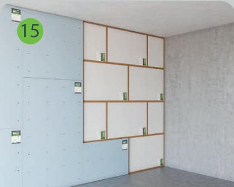
Звукоизоляционный гипсокартон Gipsoson ПЛУК монтируется без зазоров между листами. Расход саморезов SoundGuard ГП 3,9х30 составляет не менее 22 шт./м<sup>2</sup>.
