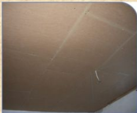
Крепление плит PhoneStar к обрешетке на потолке
