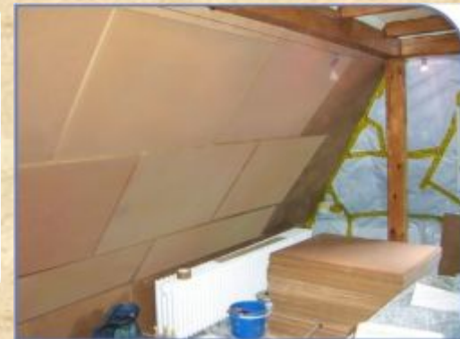
Крепление плит PhoneStar к плитам ОСБ мансардного перекрытия
