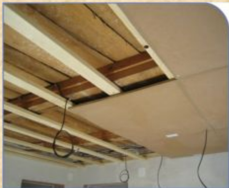
Крепление плит PhoneStar к обрешетке на потолке
